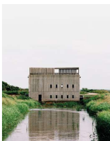
Skjern Å Pumpestationer Opført 2016
