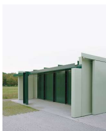
CODAN sekundær bygning Køge, opført 2023
