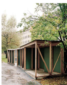
Nørrehus, København Opført 2016
