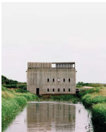
Skjern Å Pumpestationer Omdannelse af tre pumpestationer, 2016
