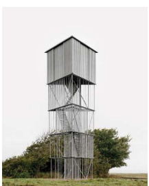
Tippertårnet Tipperne Delprojekt, nye besøgsfaciliteter, opført 2017
